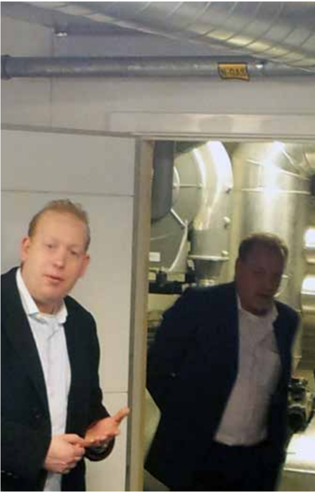
Repræsentanterne fra DFW gennemgik filterinstallationen og måtte efterfølgende svare på en masse spørgsmål og var lydhøre overfor brugernes ønsker.
